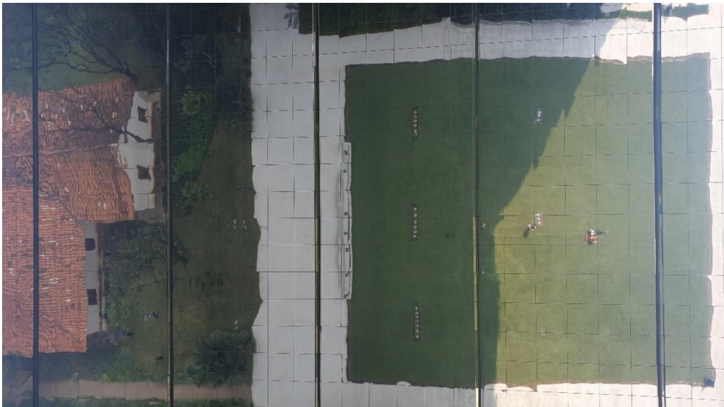
Fig.09 Vista Panorâmica do Edifício Pátio Victor Malzoni. Fonte: (Autor, 2020).
