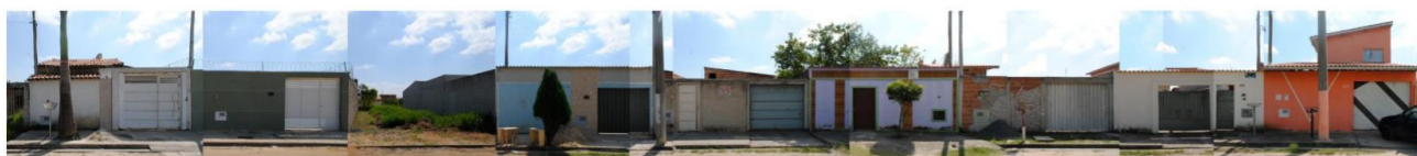
Fig. 12 – Tipologia de edificações localizadas no loteamento Jardim Primavera. Fonte: OLIVEIRA et al , 2018
