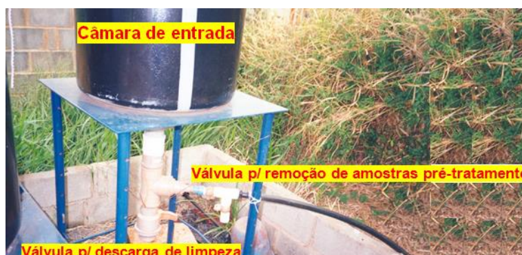
Fig. 4: Vista detalhada da câmara de entrada do esgoto.
