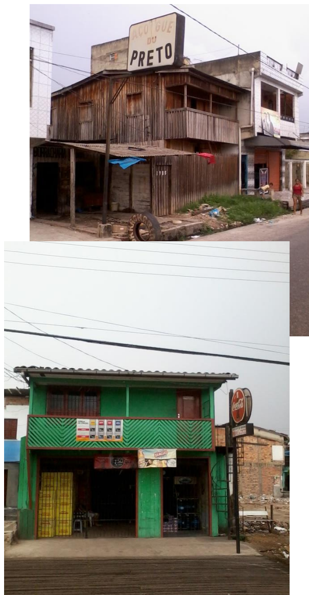
Fig 2 e 3 – Habitações com características ribeirinhas nas baixadas de Belém. Foto: Monique Leão, 2012.
