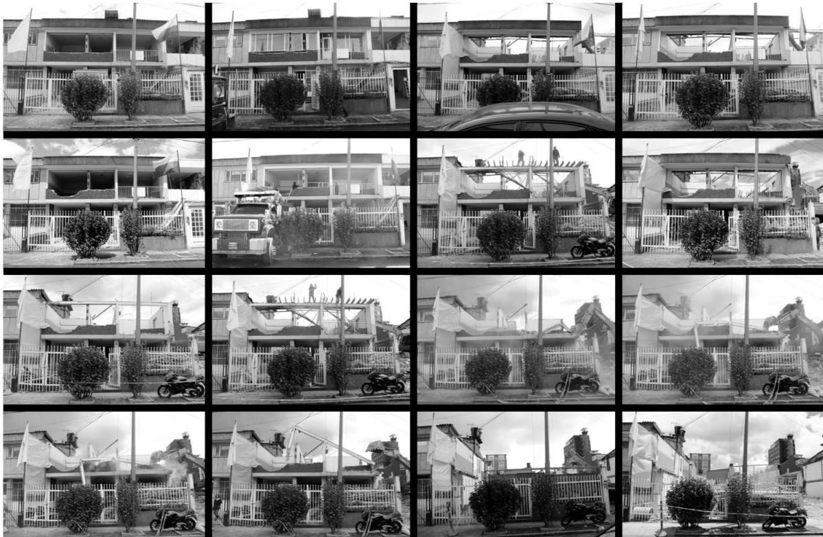
Fig.1 Secuencia de una demolición de una vivienda en Bogotá. Fuente: Fotografías archivo personal.
