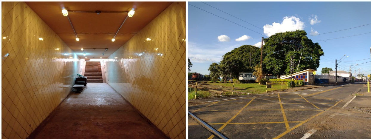
Figura 11. Foto interna do Túnel de passagem da Avenida 08 (esquerda). Vista da Avenida 8, indicando a entrada do Túnel de passagem (direita). Fonte: Acervo das autoras.
