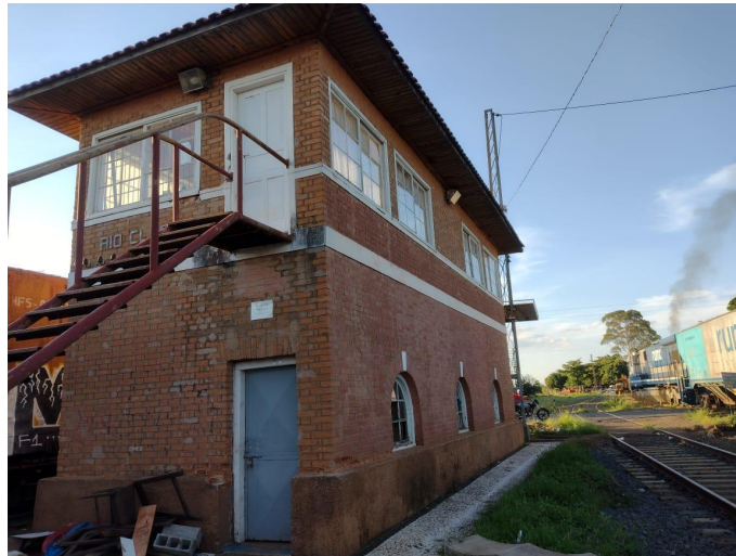
Figura 10. Cabina de chaves da Avenida 08. Fonte: Acervo das autoras.
