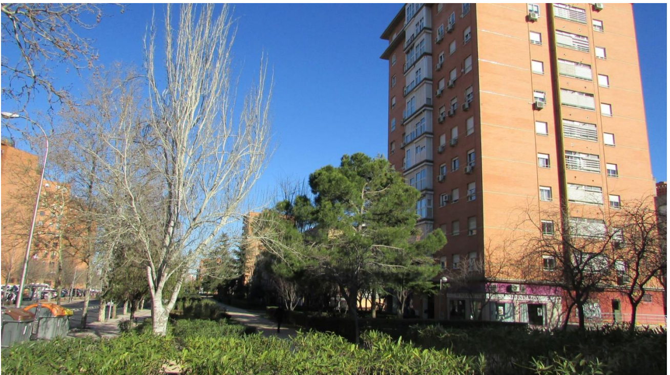
Fig. 9 Paseo ajardinado que sirve de pantalla anti ruidos contra el tráfico rodado de la Avenida de Canillejas a Vicálvaro, dentro del núcleo residencial "María Sevilla". Fuente: Fotografía del autor (2022).
