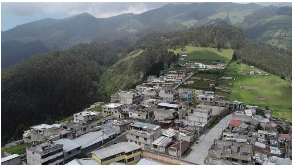
Fig. 01 Edificaciones y quebradas en Atucucho. Fuente: (el Comercio, 2016)
