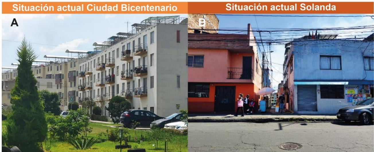
Fig. 08 Balcones Ciudad Bicentenario y terrazas Solanda. Fuente: Elaboración propia.
