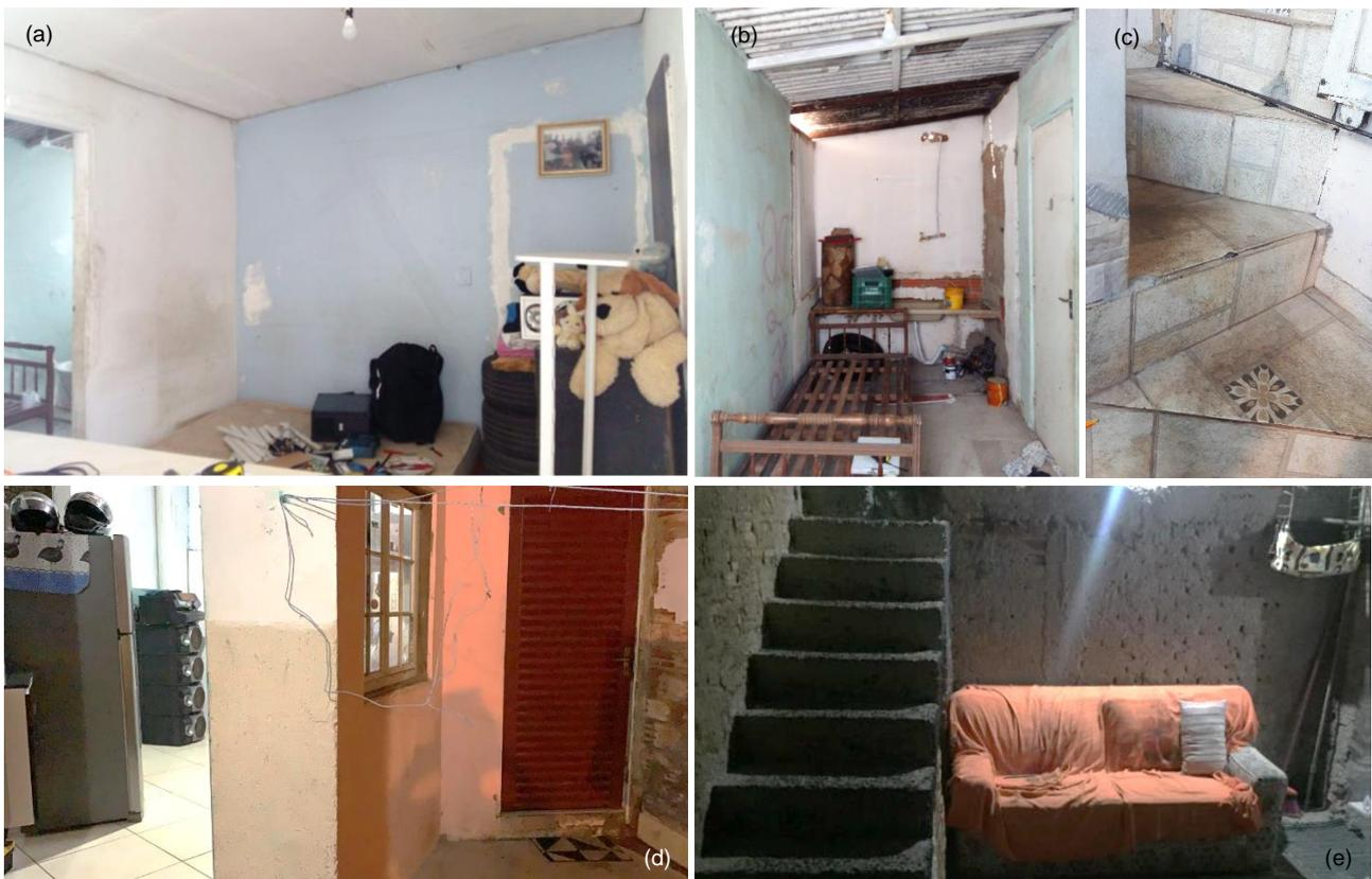
Fig. 3: Exemplos de inadequação verificados nas moradias das famílias atendidas - (a) Mofo; (b) ausência de janela e mobiliário, problemas no telhado; (c) escada irregular e corrimão (d) banheiro com acesso externo; (e) ausência de acabamento nas superfícies, falta de iluminação natural e escada inadequada. Fonte: Equipe de arquitetos da ATHIS na Vila Brandina
