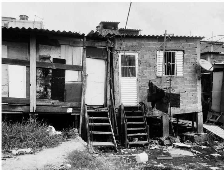
Fig 04: Conjunto de habitações na área mais precária do Lapena, elevadas do chão para evitar a entrada de água. Durante as visitas à área, foi possível notar o trabalho constante nas moradias construídas a partir de achados e restos de obra. As estacas fincadas na lama apodrecem rapidamente e precisam ser trocadas; o mesmo ocorre com a base horizontal de tábuas de madeira, sobre a qual os barracos são erguidos. Fonte: autora, 2019
