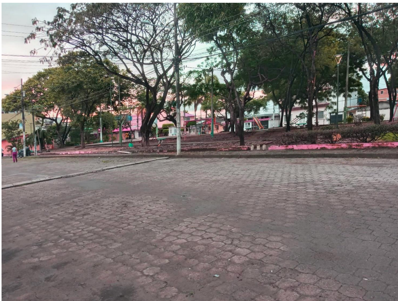
Figura 35. Parque Alborada VIII Etapa. Estado Actual. Fuente: Elaboración Autores.
