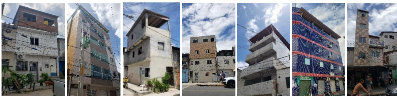
Fig. 11 - Grupo de edificações com mais de 3(três) pisos. Fotos: Autor
