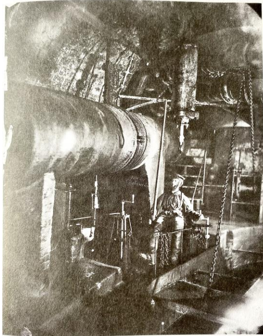
Figura 2: Imagen de las galerías de servicios de París en funcionamiento hacia 1864, donde además de su escala puede notarse la complejidad de conducciones de agua potable en su lomo y dispositivos de mantenimiento de efluentes cloacales en su fondo. Fuente: (Gandy, 2014:35)
