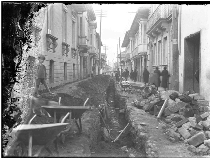
Fig. 04. Foto Canalización redes de alcantarillado. Cortesía del Museo de Bogotá Fuente: https://www.radionacional.co/noticia/cultura/coronavirus-exposicion-museo-bogota
