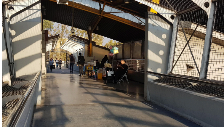
Fig. 10 Estación Los Presidentes, pasarela de acceso y libre paso sobre el metro y la autopista. Fuente: Elaboración propia, mayo 2023.
