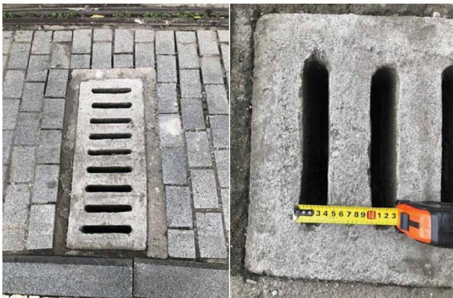
Figs. 14 e 15 - Grelhas de drenagem localizadas em rotas de pedestres e com vãos maiores que 1.5mm
