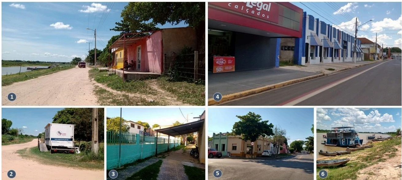
Fig. 02. Cidades gêmeas. 1;2 e 3 Carmelo Peralta/PY, respectivamente Av. Principal, Controle de migração e Ilha de Margarida. 4;5 e 6 Porto Murtinho/BR, respectivamente Av. principal, exemplares da arquitetura eclética e área portuária. Fonte: Arquivo dos autores (2024).
