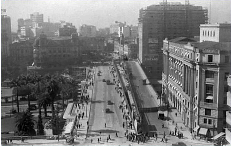
Fig. 05: Viaduto do Chá. Novo viaduto de concreto armado (esquerda) e antigo viaduto (direita). Fonte: Laamarall Netleland 1 .
