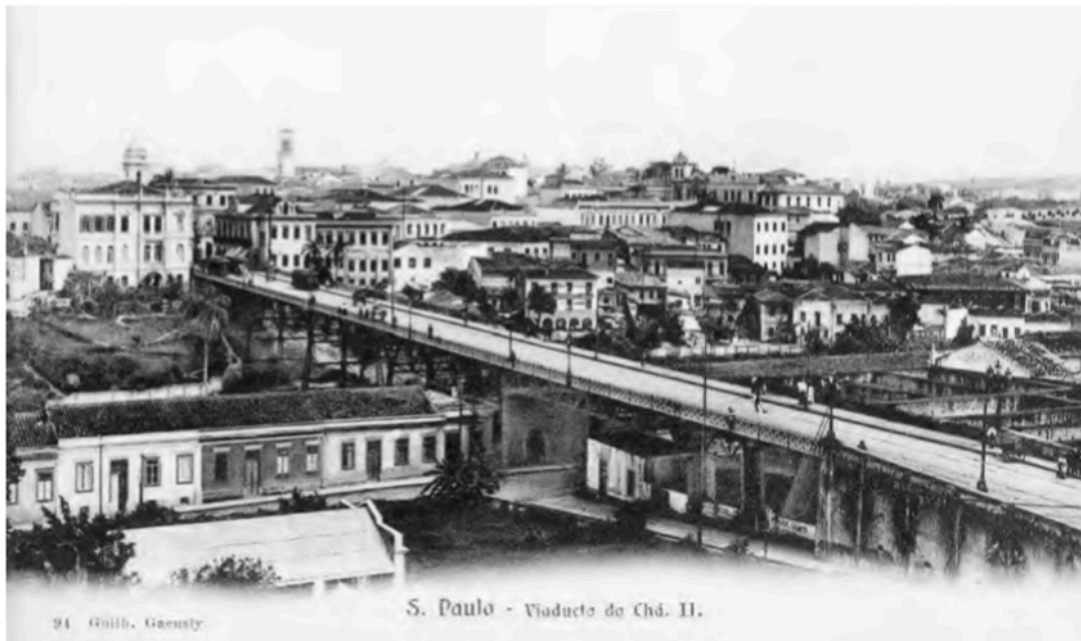
Fig. 04: Viaduto do Chá. Fonte: (Toledo, 1989).
