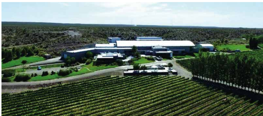
Figura 1: Finca Familia Schroeder. Vista aérea parcial hacia el sector de instalaciones, la barda y el paisaje geométrico de la producción. Proyecto 2001. Ejecución 2003-2004. Fuente: https://familiaschroeder.com/arg/bodega/
