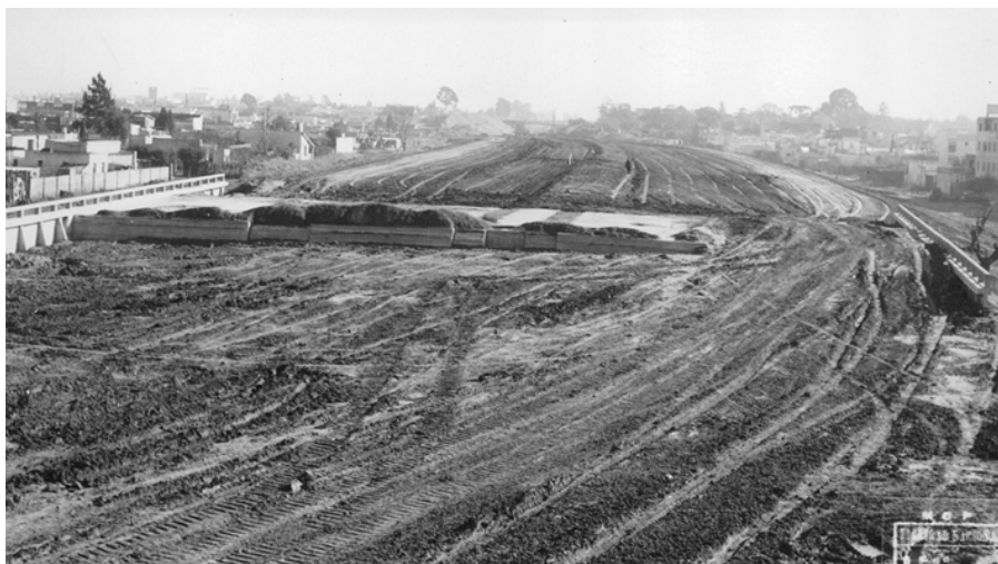
Fig. N°4. Acceso Norte a la Capital Federal (en construcción). Vista panorámica de la obra tomada desde el puente sobre vías del FCNGB, 1952. (AGN)
