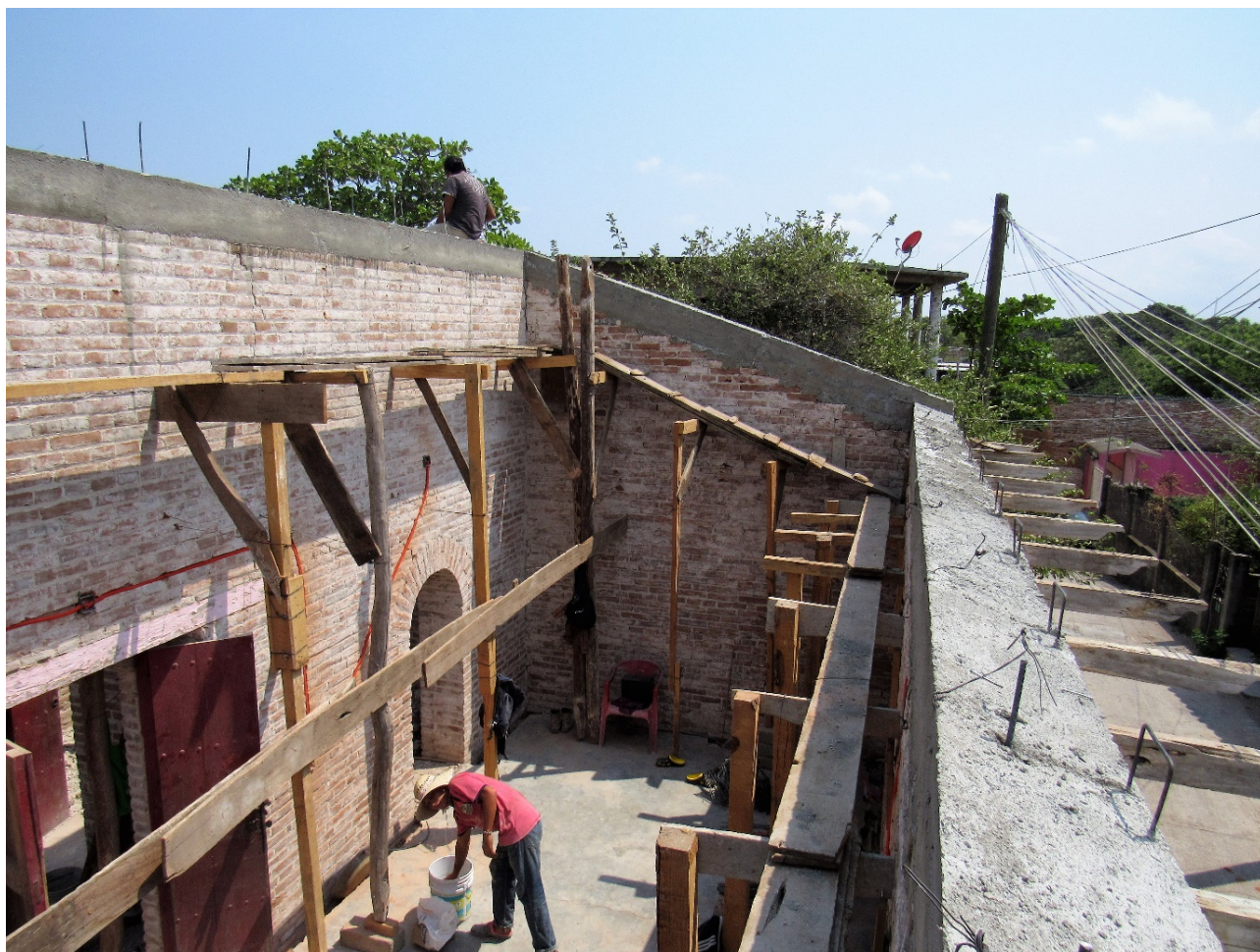
Fig. 3. Reparación y refuerzo antisísmico de una vivienda tradicional istmeña con la asesoría de una asociación civil mexicana, Ixtepec, Oaxaca. Fuente: Elaboración propia, 2018.
