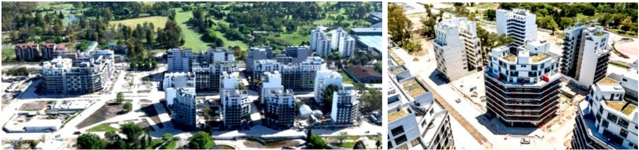
Figs. 18 y 19: VO. Avance de obra 2018. Fuente: GCBA
