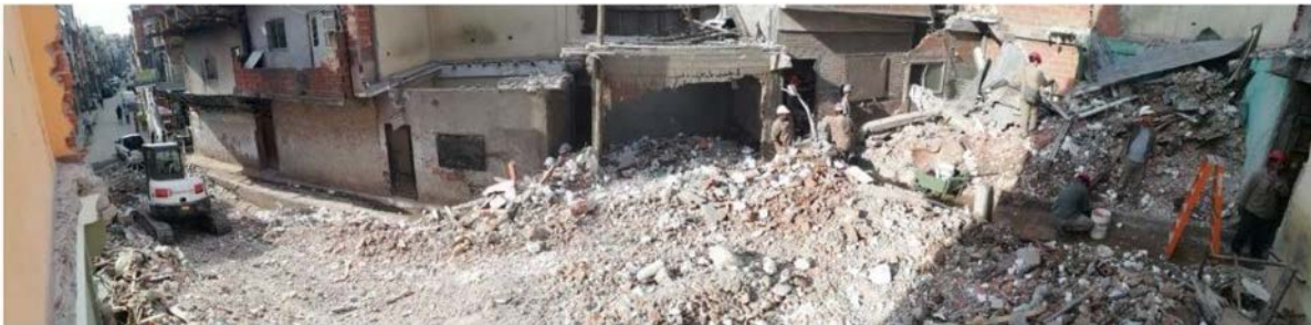
Fig. 24: V20. Demolición en curso. Año 2018. fuente: IVC - GCBA
