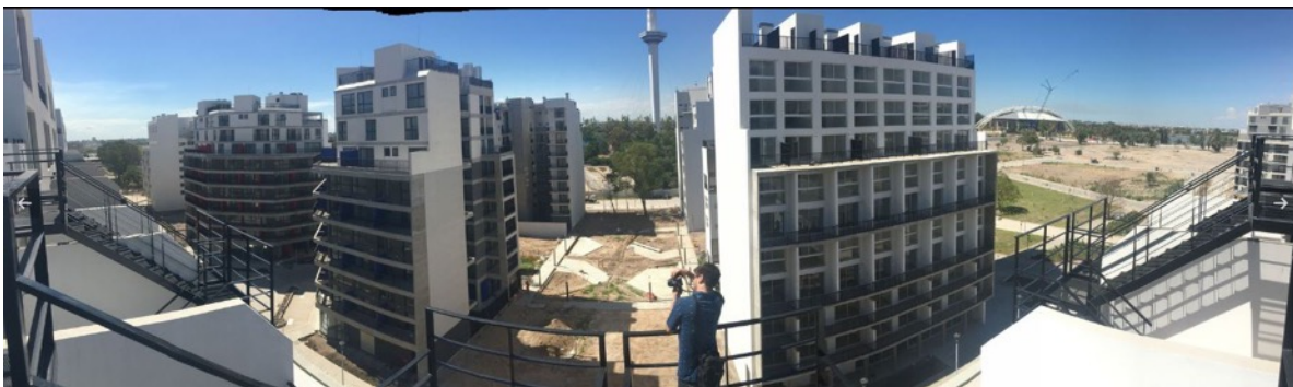
Fig. 43: VO Patio interno en manzana semi-construida. Fuente: Carballo Errasti Arqs.
