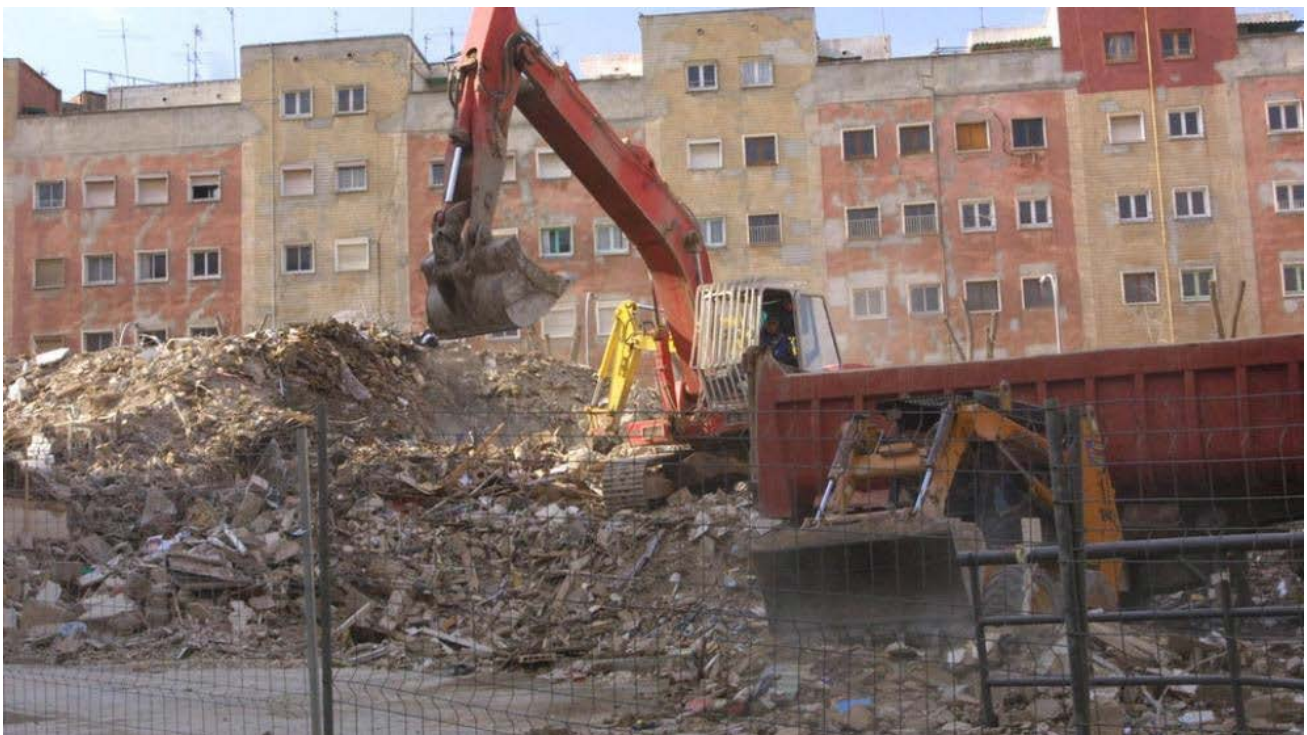
Fig. 02 Demolición vivienda publica barrio Turó de la Paire en Barcelona Fuente: (La Vanguardia, 2002)
