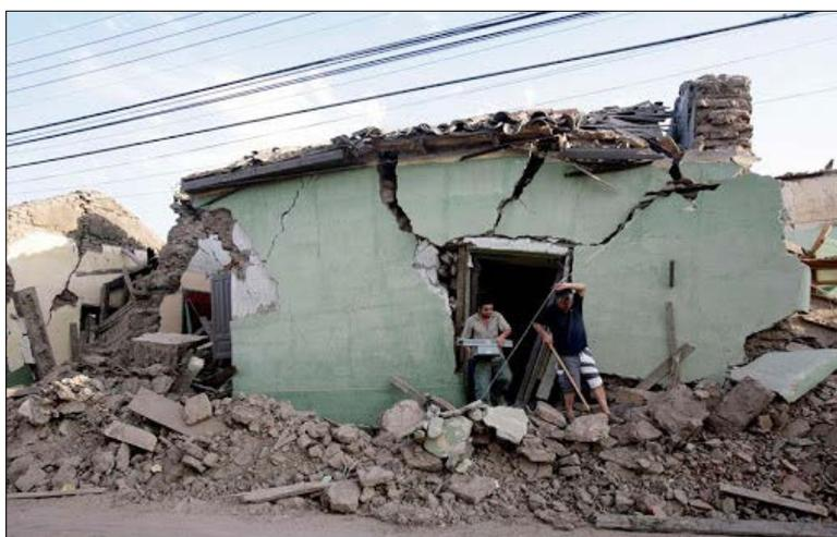
Fig. 6. Efectos en 1997 del terremoto de Punitaqui. La arquitectura popular construida en tierra y sin mayor conservación fue la más afectada. Fuente: [www.guioteca.cl](http://www.guioteca.cl), (consulta 06/03/2019).
