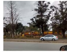
Las instalaciones ferroviarias se mantienen en desuso y en gran medida usadas como depósito de chatarras.
