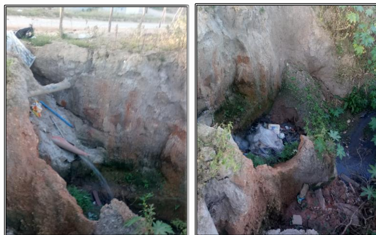
Fig.7: Imagens de despejos inadequados do esgoto coletado de loteamentos da região, em 18/09/2019. Fonte: Arquivo particular de Emmanuel de Freitas Junior, (2019).
