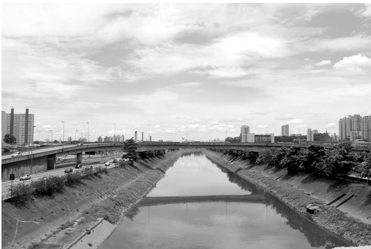
Fig. 04Canal Viário Tietê a partir da Ponte Tatuapé, 2017. Foto da autora.
